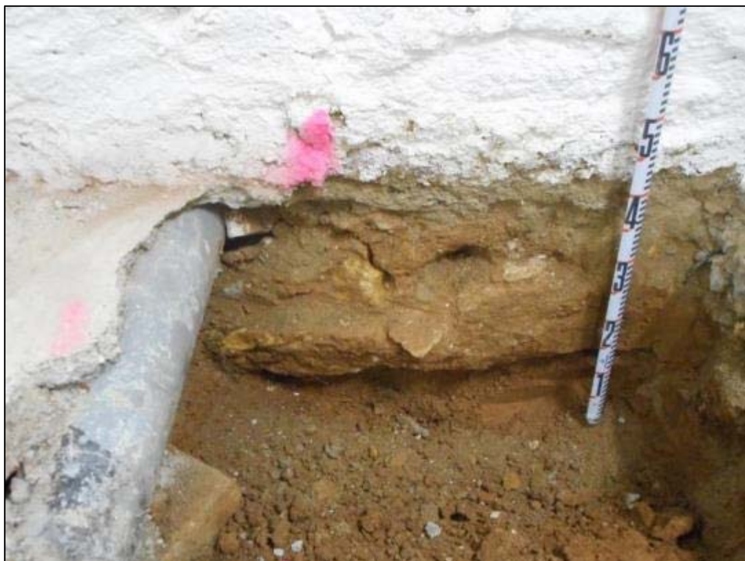
29. Detall de la fonamentació de la C4.
