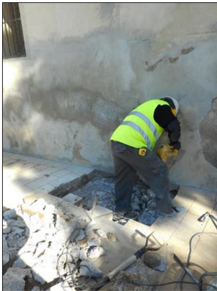
17. Inici dels treballs d'obertura de la cala C1.
