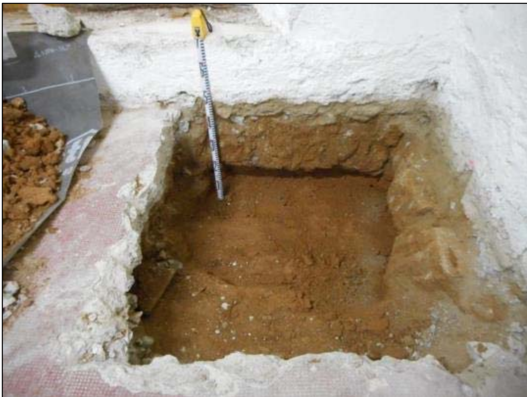
27. Cala C3 detall de la fonamentació de la paret mitgera entre la sala dels banys i la sala d'exposició.
