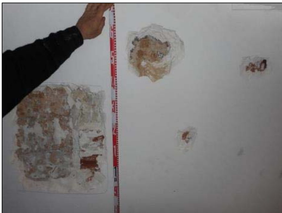
40. Cales parietals P1 situades a l'escala d'accés a la primera planta.
