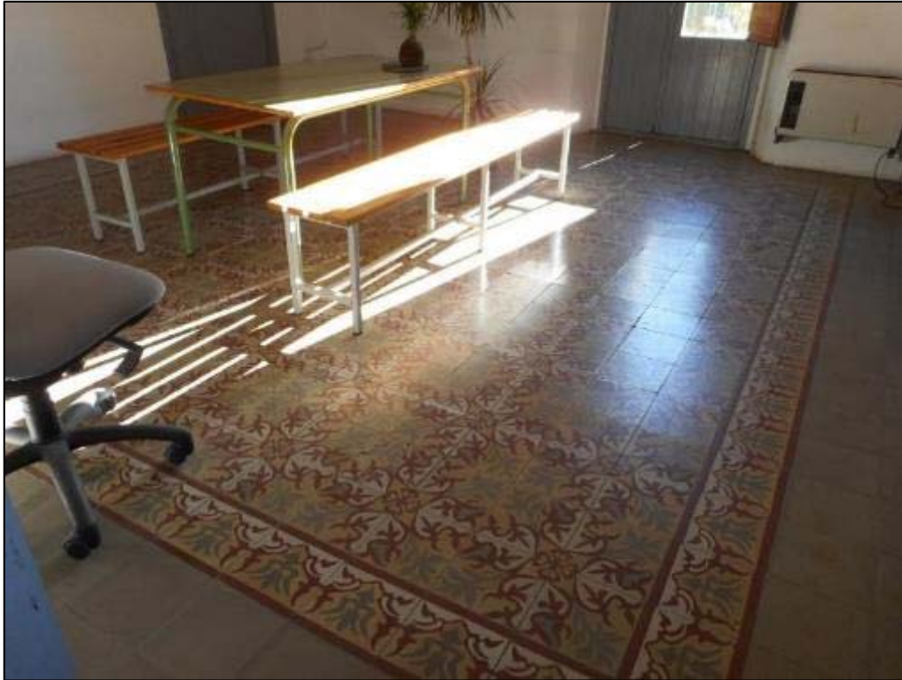
5. Paviment hidràulic present a la Sala 1 de la primera planta.
