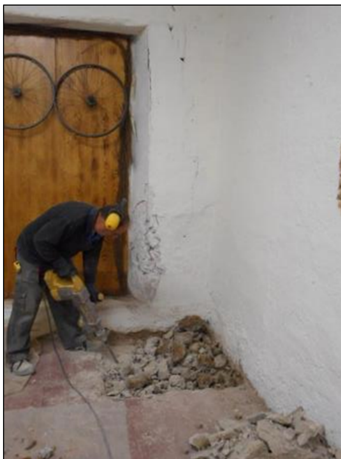
26. Inici dels treballs de realització de la C3.
