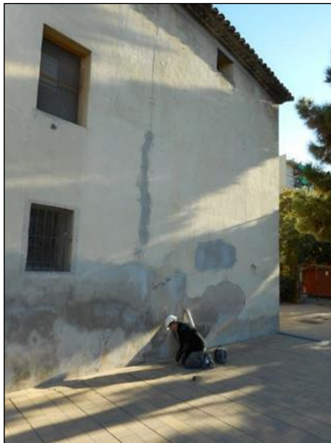
16. Inici dels treballs de la C1.
