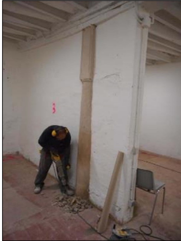
21. Inici dels treballs de la C2.
