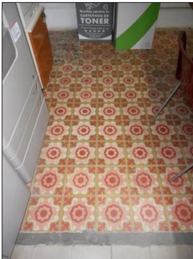
7. Paviment hidràulic de la Sala 2 present a la primera planta.
