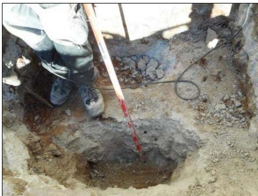
18. Capa de formigó UE004.
