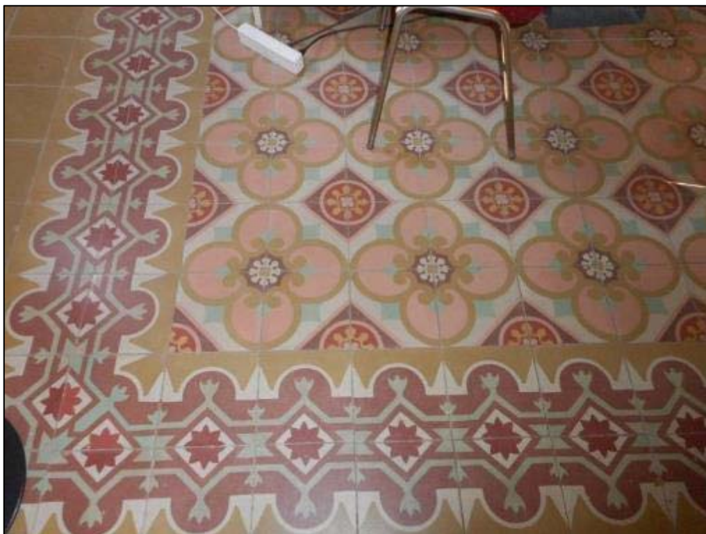
10. Paviment hidràulic present al despatx 2 de la primera planta.
