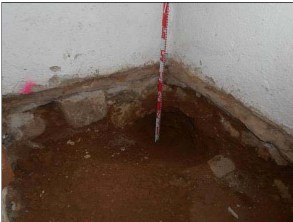
36. C5 detall de la fonamentació.
